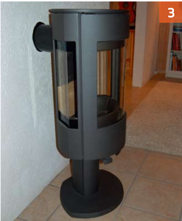
Bilde 4. Stigning røykrør. Ikke bakfall
