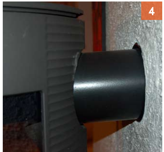
Bilde 4. Stigning røykrør. Ikke bakfall
